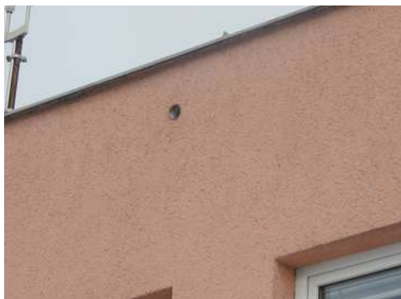
Obr. 6: Detail otevřeného větracího otvoru
